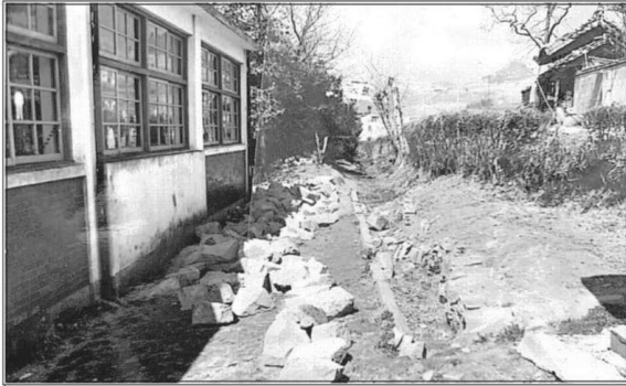
유치원 뒤뜰 공사현장(1994.03.26.)
